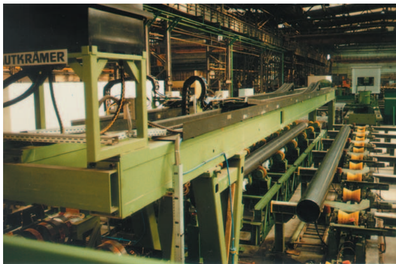
采用门架式设备在精整车间对ERW钢管进行检测
